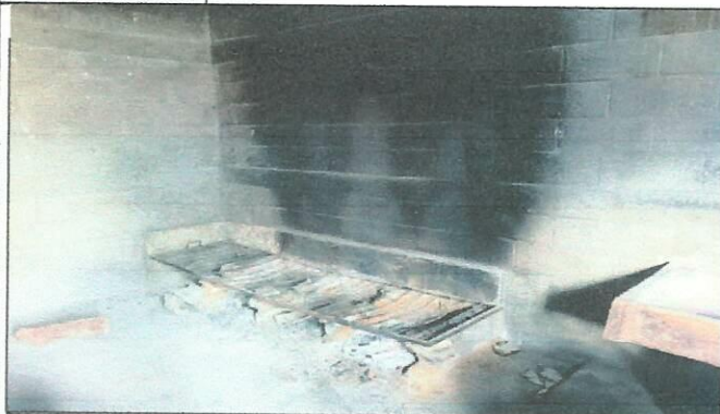
Foto 1: Remozamiento de la Cocina Escolar que se encuentra actualmente en su interior en este estado, que incluye, repello y pintura de paredes interna y externa, colocación de piso cerámico antideslizante.
